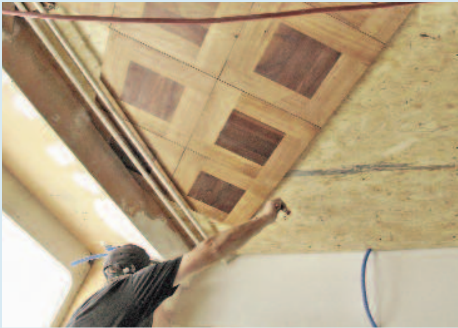
Ungewöhnlicher Arbeitsort: Die Bodenleger verlegten Parkett an der Decke des Modegeschäfts Fizzen.
